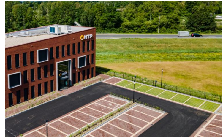
Bij het kantoor van NTP in Hattem is een mix gebruikt van volledig en met grasbetontegels verharde parkeervakken.
